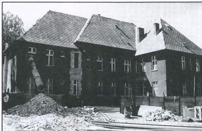
Remontowana przychodnia w dzielnicy Paruszowiec.
