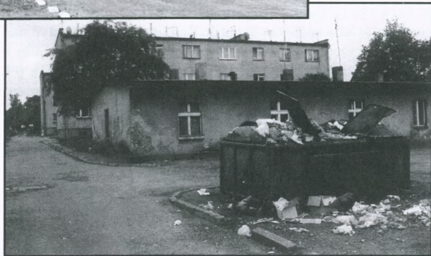
"Leżące wieżowce" i bloki przy ulicy Janiego na Wawoku.
