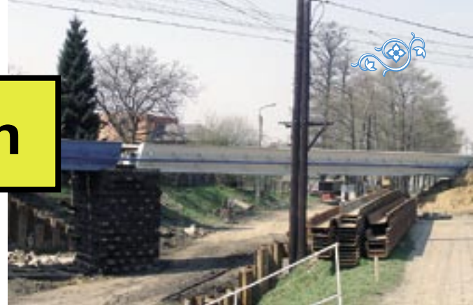
Trwa remont wiaduktów na ul. Zebrzydowickiej.
