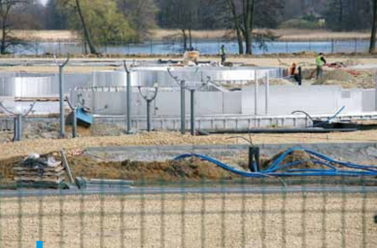
Na kąpielisku Ruda już wkrótce rozpocznie się montaż solarnej plaży
