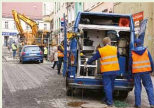
W Popielowie w sąsiedztwie tamtejszej podstawówki budowlancy uwijają się przy budowie przedszkola.
