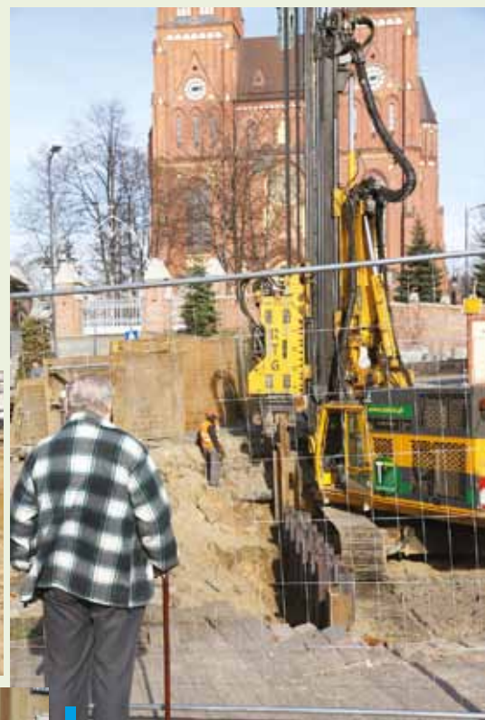
Mieszkańcy z zaciekawieniem przyglądają się robotom związanym z rewitalizacją ulic na linii bazylika św. Antoniego - rynek
