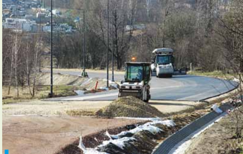
Nowy odcinek ul. Prostej powoli nabiera kształtów. Właśnie rozpoczęło się asfaltowanie jego nawierzchni
